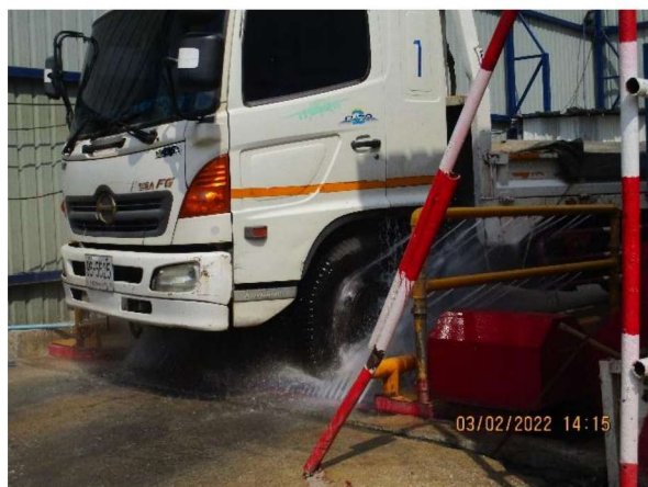
รูปที่ 2-25 การล้างล้อรถบรรทุก
