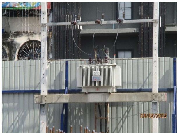
รูปที่ 2-49 หม้อแปลงไฟฟ้าประจำพื้นที่โครงการ
