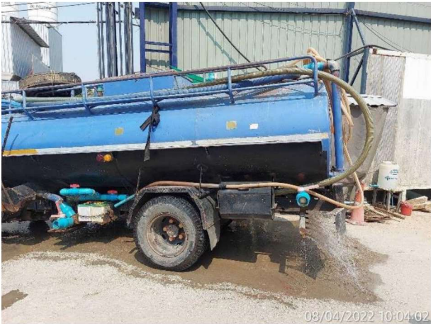
รูปที่ 2-19 การฉีดพรมน้ำและทำความสะอาดเพื่อลดฝุ่นละออง บริเวณถนนรอบพื้นที่ก่อสร้าง
