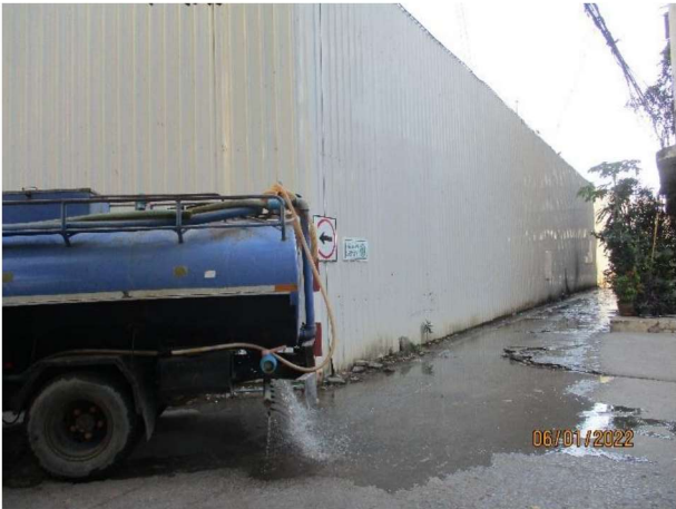
รูปที่ 2-19 การฉีดพรมน้ำและทำความสะอาดเพื่อลดฝุ่นละออง บริเวณถนนรอบพื้นที่ก่อสร้าง
